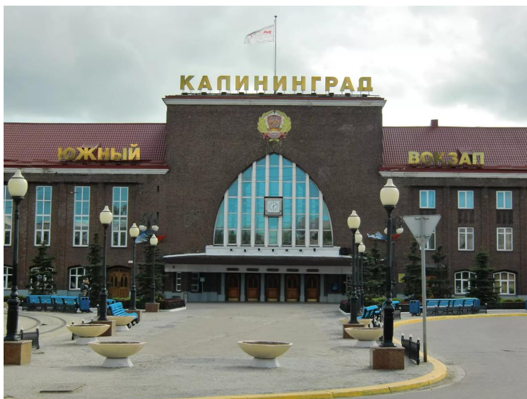
Железнодорожный вокзал Калининград-Южный построен в 1929 году. Во время штурма Кёнигсберга был разрушен. Вокзал был вновь введен в эксплуатацию в сентябре 1949 года.
